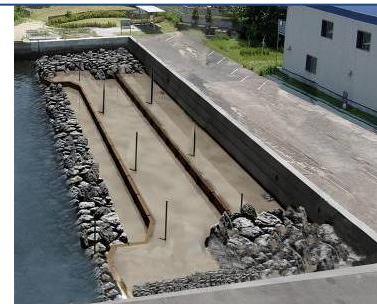
生物共生型護岸の整備
